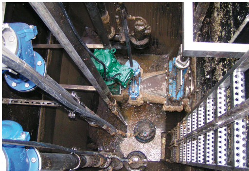
Abb. 5: Testphase des Doppelwellen-Zerkleinerers (provisorischer Einbau)
