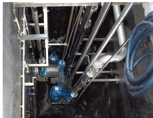
Abb. 6: Pumpenstation nach dem Komplettumbau (zwei baugleiche Pumpen sowie der Doppelwellen-Zerkleinerer)
