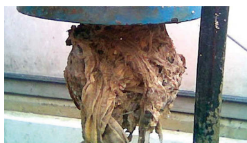
Abb. 2: Zopfgebilde am Saugstutzen der Pumpe
